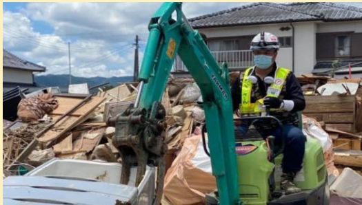
熊本地震で被災した家屋の復旧作業の様子。
