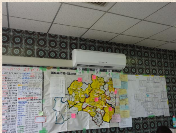
災害ボランティアセンターにエアコンを設置
